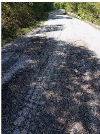
Εικόνα 30. Ρωγμές τύπου αλιγάτορα με σοβαρή αποκόλληση υλικού και ανεπτυγμένο μοτίβο σε μεγάλο μήκος της οδού
