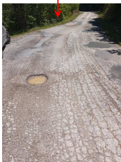
Εικόνα 34. Υψηλής σοβαρότητας ρωγμές τύπου αλιγάτορα,, με σημαντική αποκόλληση υλικού και δημιουργία λακκουβών άνω των 2,5cm
