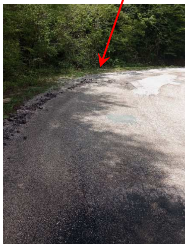
Εικόνα 28. Υψηλού επιπέδου σοβαρότητας θραυσμένος & αποκολλημένος ασφαλτοτάπητας
