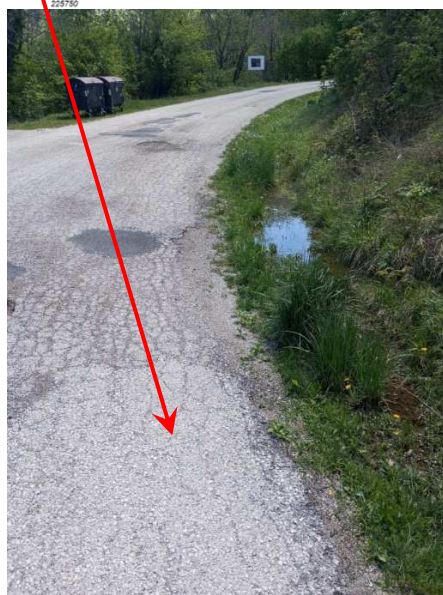
Εικόνα 33. Ρωγμές τύπου αλιγάτορα μεσαίου επιπέδου, με ανα σημεία αποκόλληση υλικού και δημιουργία λακκούβων
