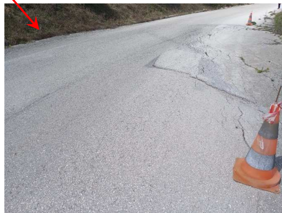
Εικόνα 10. Εξυγίανση καχιζάνουν οδοστρώματος & κατασκευή τοιχείου για την ενίσχυση κάθε φέρουσας ικανότητας του πρανούς
