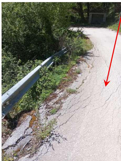
Εικόνα 40. Τοπική καθίζηση οδού πλησίον της εξόδου του τεχνικού
