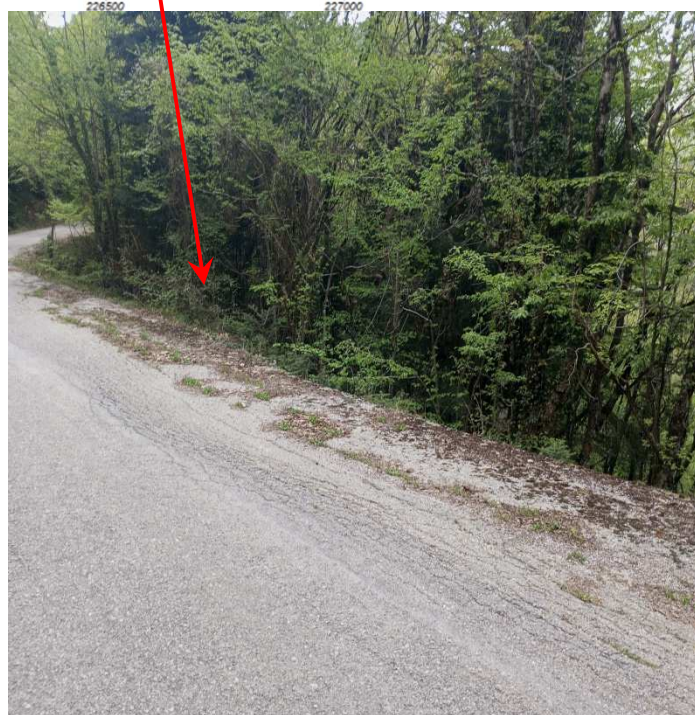
Εικόνα 39. Τοπική καθίζηση οδού στα όρια του οδοστρώματος στην στέψη του πρανούς
