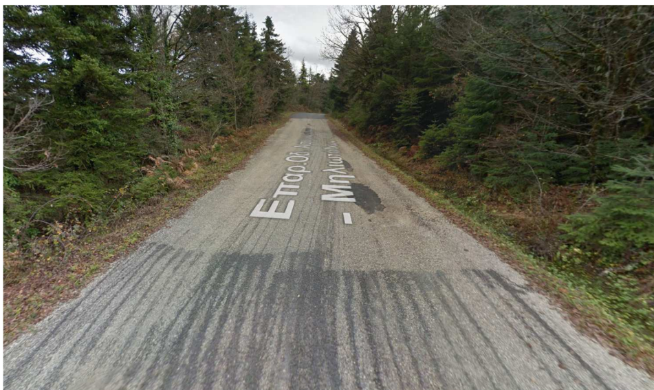
Εικόνα 13. Οπτική Επισκόπηση: 1. Λακούβες 2. Αποκόλληση & ρηγμάτωση στα άκρα του οδοστρώματος
