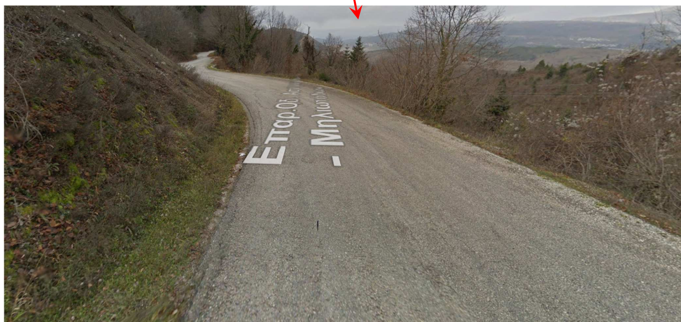
Εικόνα 12. Ρηγματώσεις στα άκρα του οδοστρώματος- Αποκολλήσεις ασφάλτου- Λείανση αδρανών
