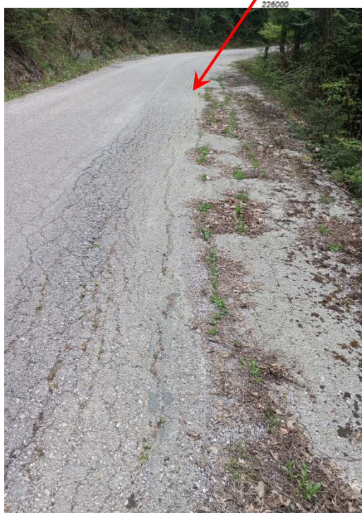
Εικόνα 38. Ρηγμάτωση ασφαλτοτάπητα λόγω καθίζησης της οδού
