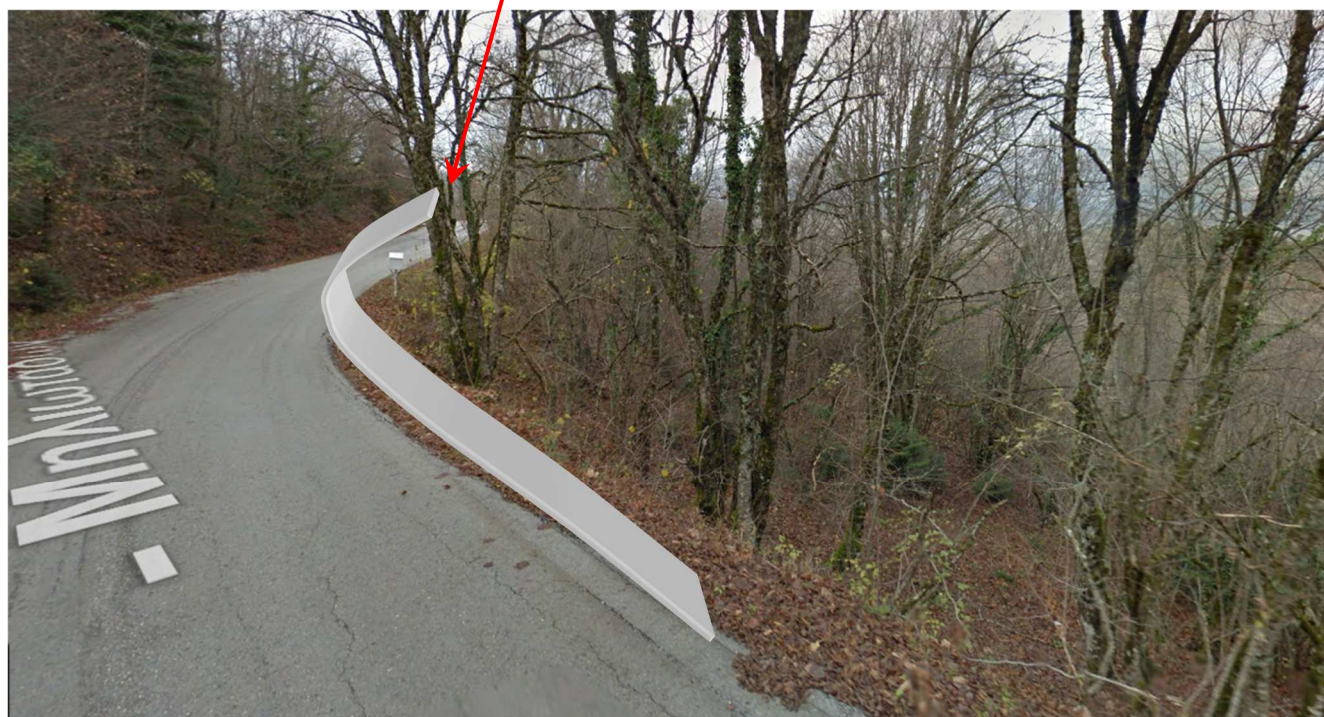
Εικόνα 11. Τοποθέτηση Στηθαίου Ασφαλείας στη οριογραμμή του επιχώματος
