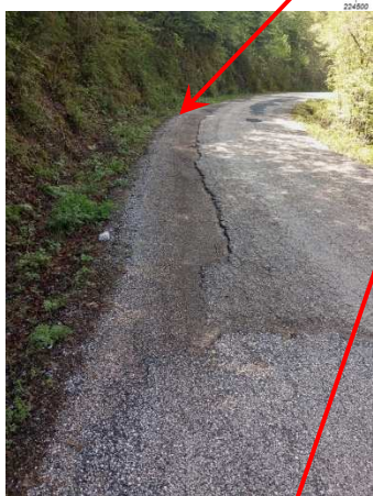
Εικόνα 26. Υψηλού επιπέδου σοβαρότητας θραυσμένος & αποκολλημένος ασφαλτοτάπητας στα άκρα του οδοστρώματος
