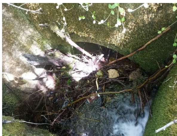
Εικόνα 42. Είσοδος Τσιμεντοσωλήνα (0,60 διάμετρος)
