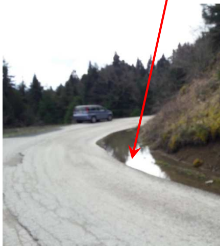
Εικόνα 22. Συγκράτηση των νερών στην βάση του πρανούς
