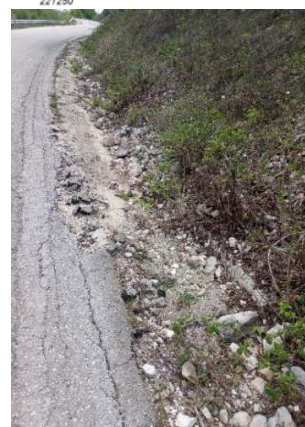
Εικόνα 6. Επενδεδυμένη Τάφρος (2)- Ρηγματώσεις στα άκρα του οδοστρώματος
