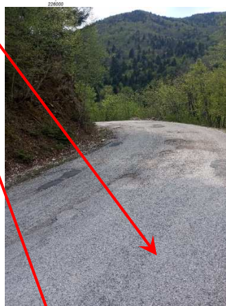
Εικόνα 27. Μέτριας σοβαρότητας (>2,5cm) λακούβες κατά μήκος της οδού λόγω αποκόλλησης του ασφαλτοτάπητα
