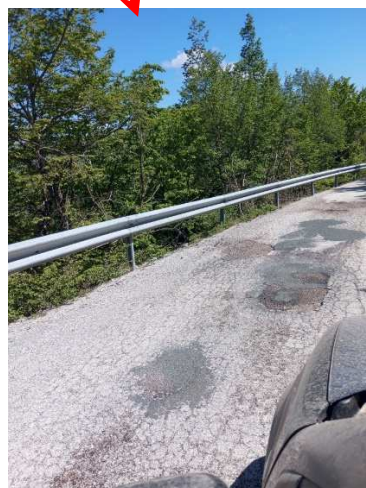
Εικόνα 29. Λακούβες (>2,5cm) κατά μήκος της οδού λόγω αποκόλλησης του ασφαλτοτάπητα
