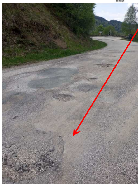
Εικόνα 32. Μεσαίου και υψηλού επιπέδου σοβαρότητας (>50mm) λακκούβες κατά μήκος της οδού
